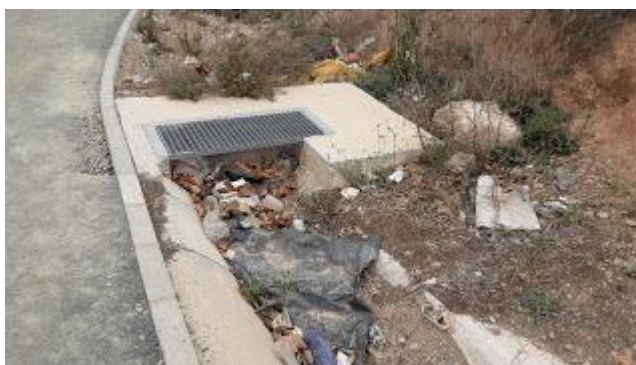
Canales de recogida de aguas totalmente embozados.
