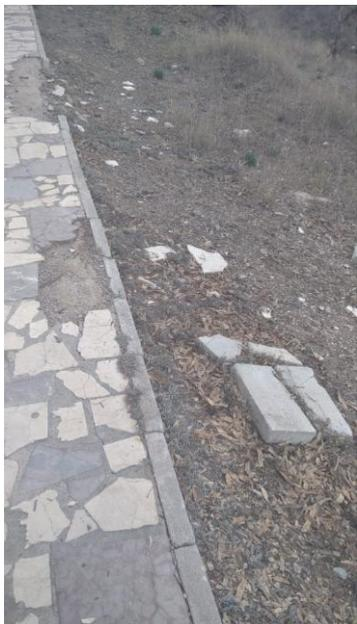
**6. El sendero de subida a El Valle está muy deteriorado con losas levantadas y socavones, como se puede apreciar en la foto. ¿Cuándo se va a reparar?**
